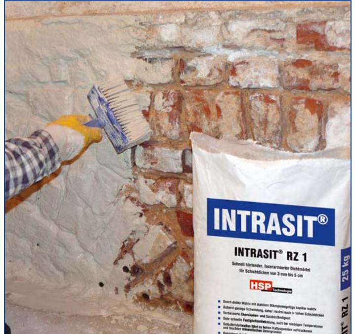
**INTRASIT® RZ 1** wirkt selbstkristallisierend, härtet schnell und rissfrei aus. Ist einsetzbar als Dichtungsschlämme oder -mörtel, zur Reparatur und Reprofilierung, als Hohlkehlmörtel oder als Haftspritzbewurf im RZ-System.
