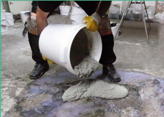
HADAPLAN® BM wird mit Wasser zu einer homogenen Spachtelmasse angerührt
