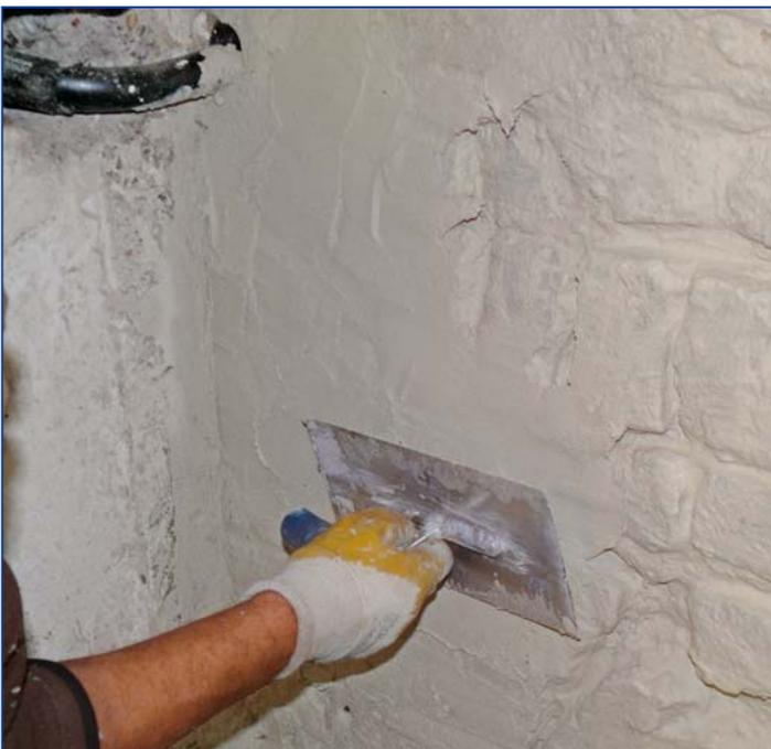
**INTRASIT® RZ 2** zieht schnell an und härtet schwind- und rissfrei aus, wirkt ausgleichend auf Schwankungen des Raumklimas. Zeichnet sich durch eine feine Kornstruktur und helle Farbgebung aus, ...
