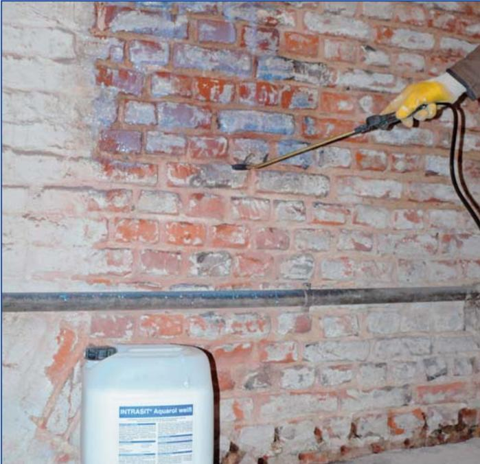
**INTRASIT® Aquarol weiß** wirkt verfestigend, staubbindend und wasserabweisend. Besitzt ein hohes Eindringvermögen und ist auf allen mineralischen, trockenen oder mattfuchten Untergründen einsetzbar.
