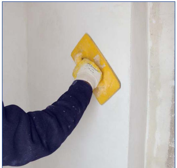
... bietet eine „tapezierfähige Oberfläche“, keine weitere Nachbehandlung nötig. Als Sanier- und Klimaputz auch auf Porenbeton einsetzbar, entspricht DIN EN 998.
