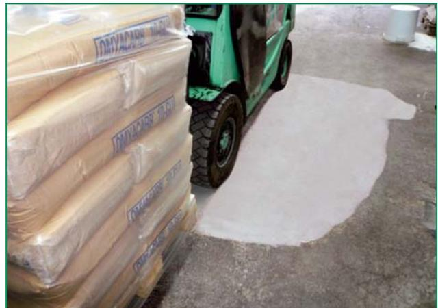
HADAPLAN® BM ist bereits nach ca. 90 Minuten Durchhärtezeit hoch belastbar – hier z.B. mit einem Stapler mit einer Drucklast von ca. 1000 kg/Rad
